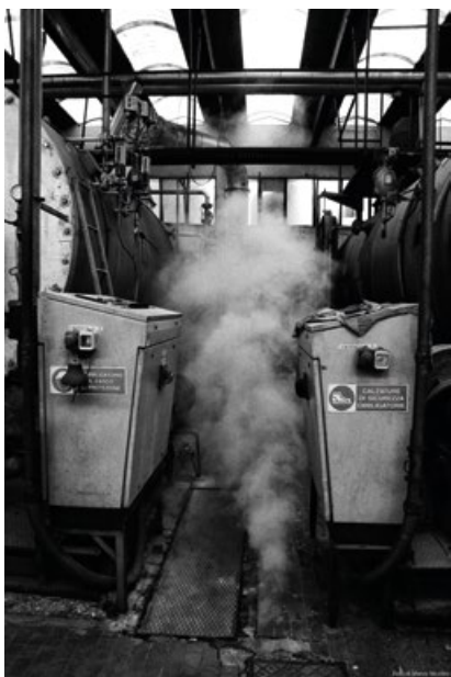
Figura 6 – Particolare della centrale termica.
