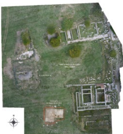
Ortofoto generale dell'area forense da drone
