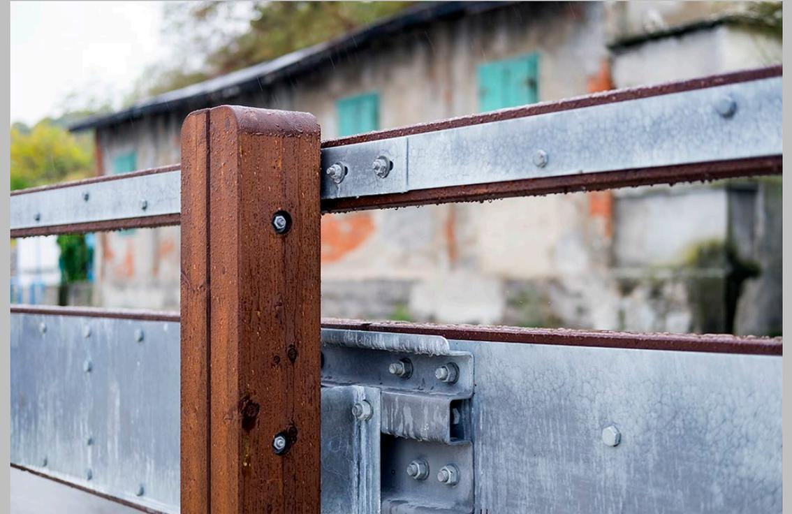
Uso di acciaio corten in zone battute dal moto ondoso, è necessaria zincatura di elevato spessore
