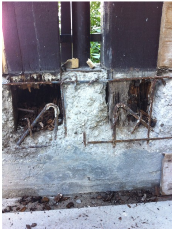
Figura 2.1: Pilastrini di legno incastrati alla base in bicchieri di calcestruzzo.
