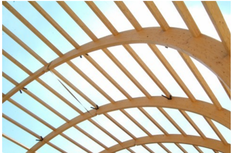
Figura 2.2: Archi a tre cerniere di legno lamellare a copertura di una palestra.
