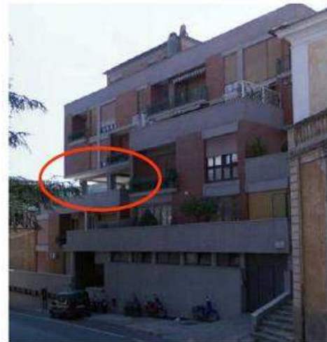
Figura 9 – Esempio di collasso dovuto a cedimento di piano “soffice” - L’Aquila, 2009
