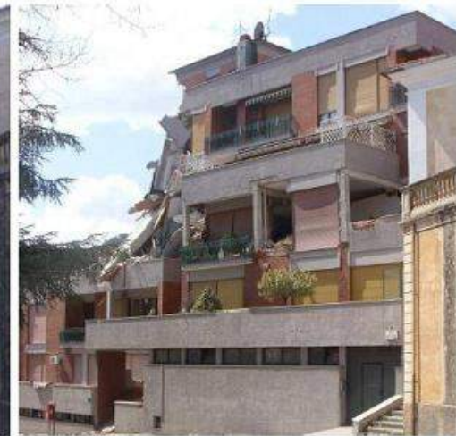
Figura 9 – Esempio di collasso dovuto a cedimento di piano “soffice” - L’Aquila, 2009
