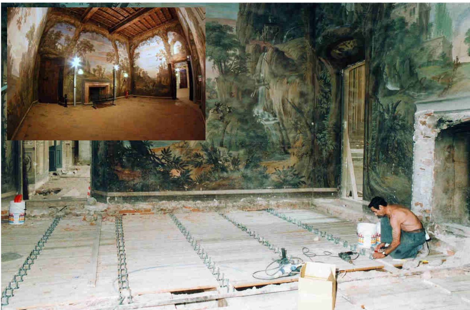
Alte portate (600 kg/mq) in spessori ridotti ( Villa Borromeo, Cesano Maderno (MI) )
