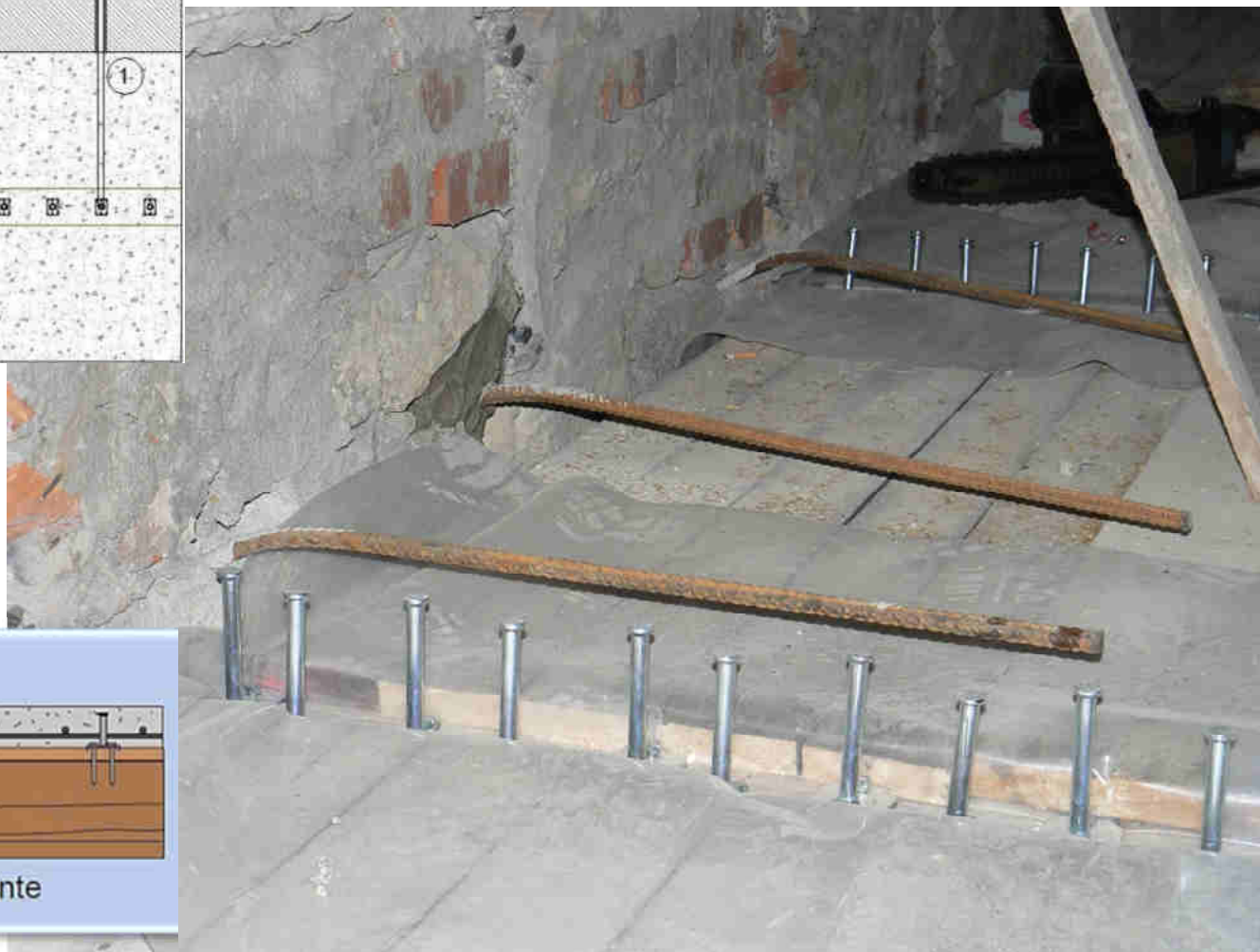
Collegamento puntuale alle murature con barre
