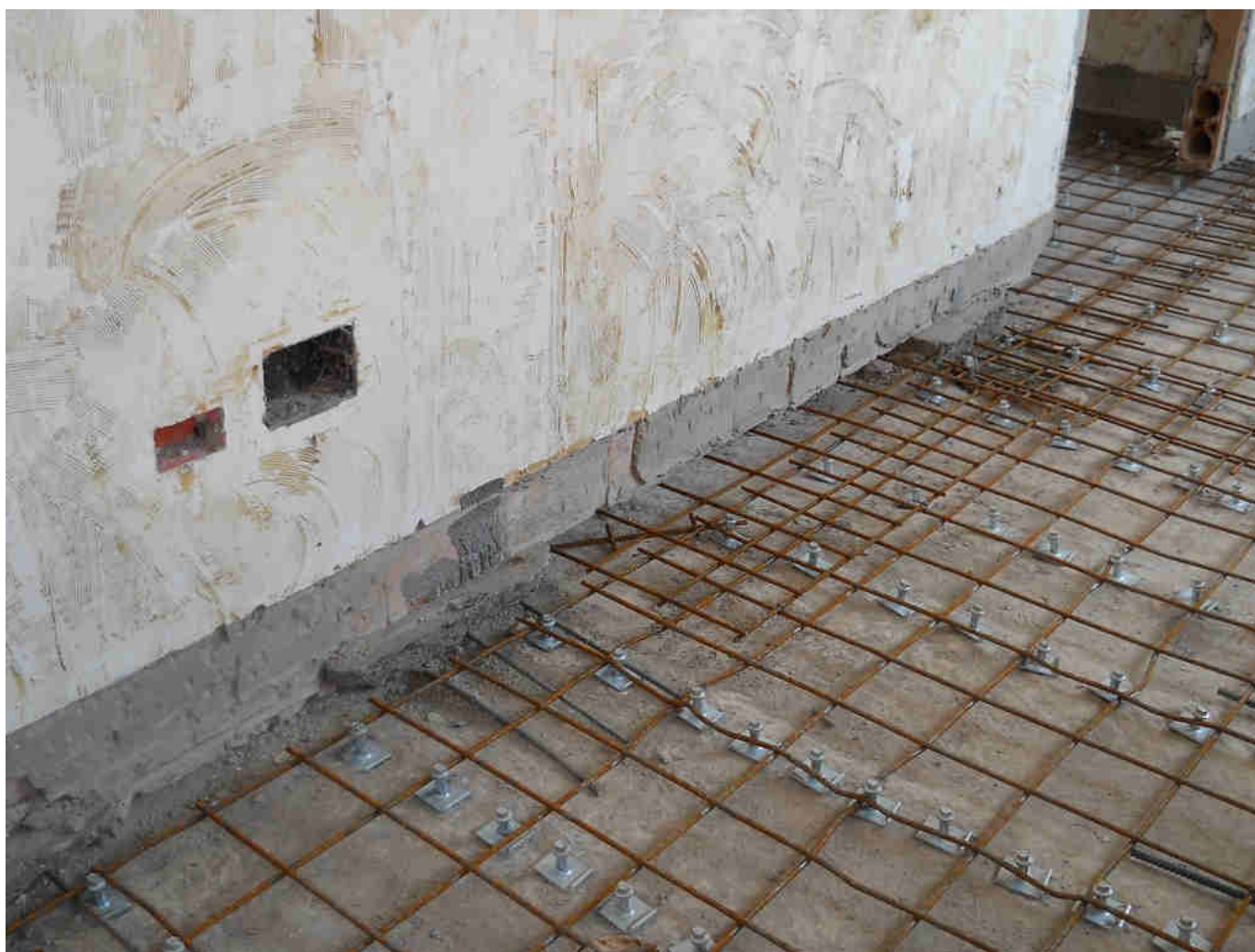
Fissaggio dei connettori
