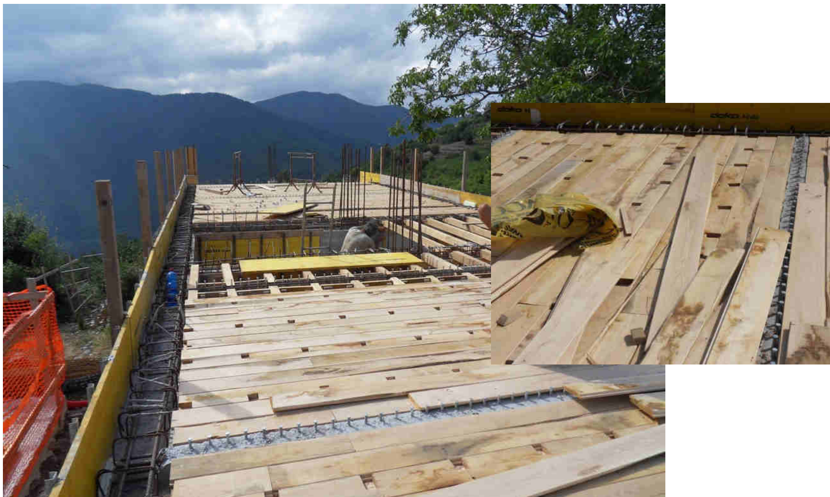
Connettore BASE carotatura quadrata
