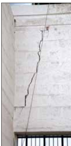
Figura 6.10: Esempi di fessurazione di pannelli di tamponatura interni (terremoto Emilia-Romagna 2012, Mirandola (MO))
