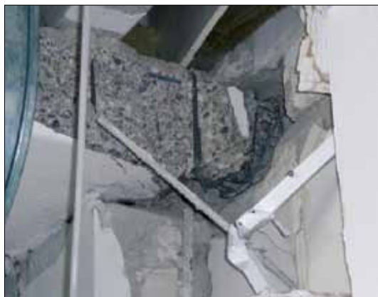
Figura 5.1 a), b) e c): Danneggiamento locale con espulsione del copriferro causato da insufficienti dettagli di armatura. Livello di danno nelle travi e nei pilastri: D3 (terremoto Abruzzo 2009).
