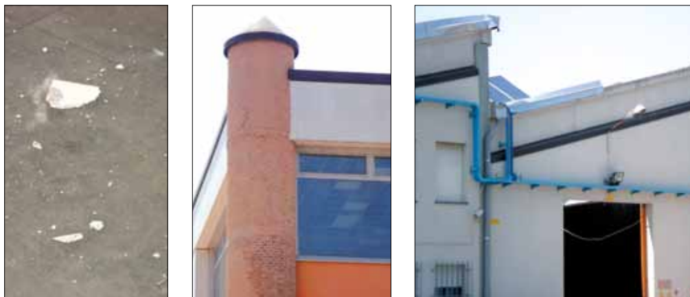
Figura 6.14: Esempi di danni ad elementi non strutturali secondari: (a) caduta di intonaco (Mirandola (MO), maggio 2012) ; (b) fessurazione di un torrino in muratura (Medolla (MO), maggio 2012); (c) caduta di una grondaia in acciaio (terremoto Emilia-Romagna 2012, San Felice sul Panaro (MO))
