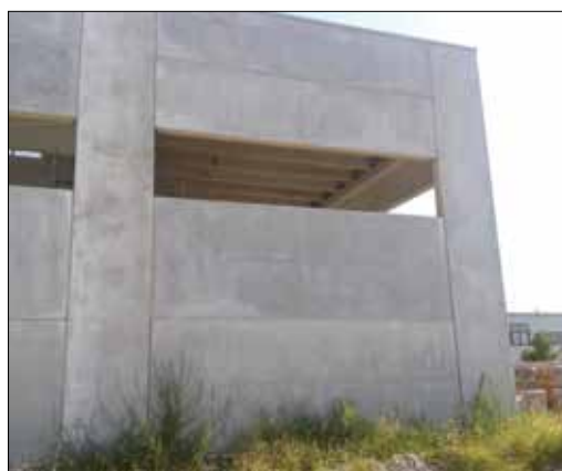
Figura 4.24. Pannelli prefabbricati orizzontali.
