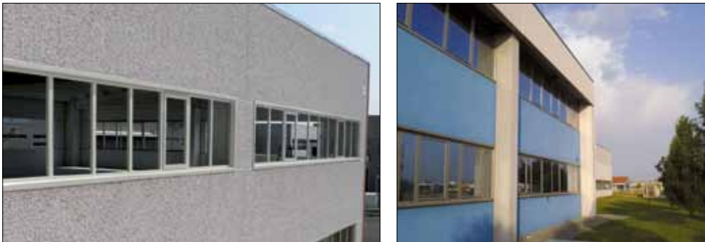
Figura 4.13. Esempi di finestratura a nastro in strutture prefabbricate esistenti.
