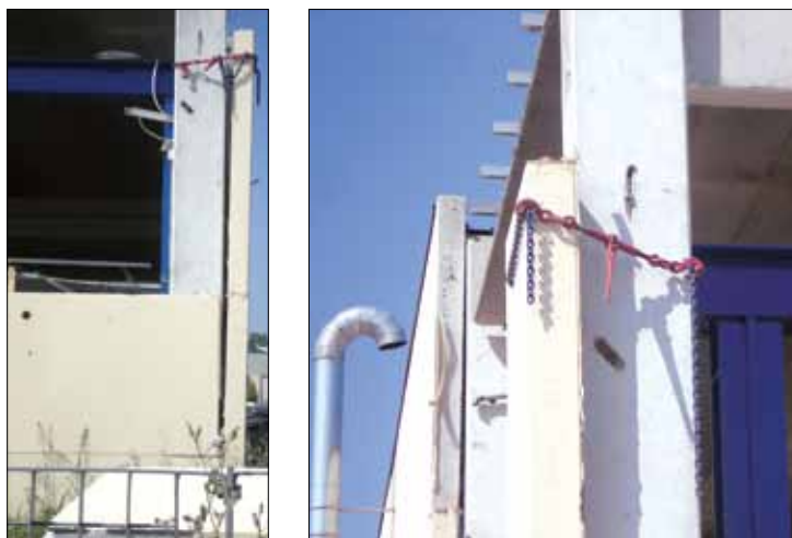
Figura 6.13: Esempi di provvedimenti di pronto intervento eseguiti, non previsti nell'elenco proposto nella scheda: imbracatura di pannelli prefabbricati di facciata per impedire il loro imminente collasso a causa del danneggiamento della connessione pannello-pilastro (terremoto Emilia-Romagna 2012, San Felice sul Panaro (MO))
