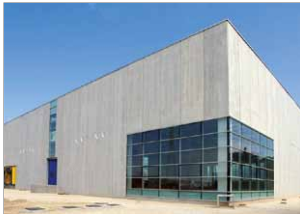
Figura 4.30. Struttura prefabbricata con pannelli di tamponamento tipo sandwich.
