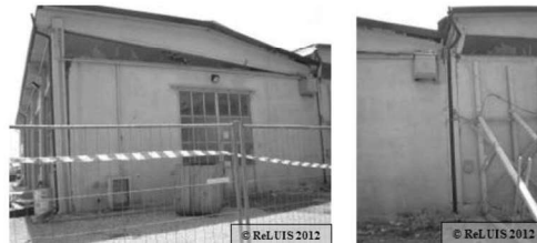
Figura 2 – Perdita di appoggio della trave principale a sezione variabile in un edificio monopiano prefabbricato con travi principali trasversali di non recente costruzione a causa della crisi a taglio del pilastro di appoggio, reso tozzo dalla configurazione del pannello di tamponatura
