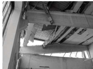
Figura 7 - Perdita di appoggio della trave in un edificio monopiano prefabbricato con travi principali trasversali
