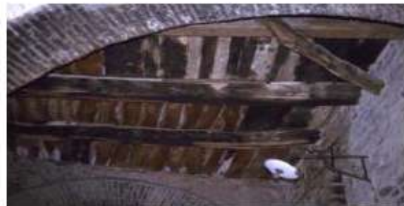
Solaio in legno con tavolato a semplice orditura
