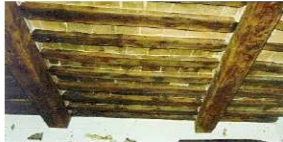
Solaio in legno con mezzane
