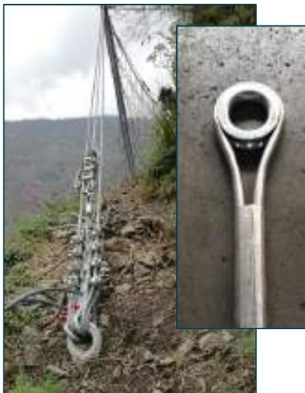
Gli ancoraggi C-FAST sono caratterizzati dalla presenza di un rinforzo circolare (ovvero una boccola in acciaio), inserito in stabilimento in fase di produzione, della testa dell'ancoraggio (asola), atto a mitigare gli effetti di pressoflessione e dunque evitare l'insorgere di forze di taglio sulla fune in corrispondenza dell'asola.
