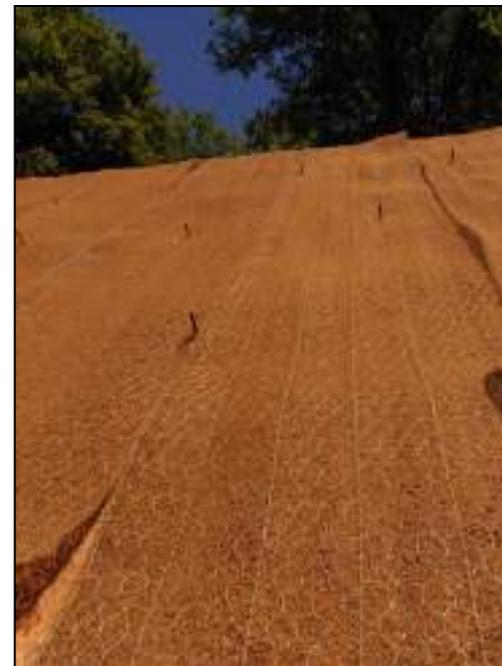
Rivestimento anti-erosivo ad elevata rigidezza
