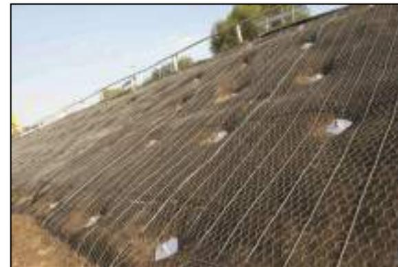
Ripristino di dissesto idrogeologico mediante riprofilatura, regimentazione delle acque superficiali, consolidamento e rivestimento anti-erosivo
