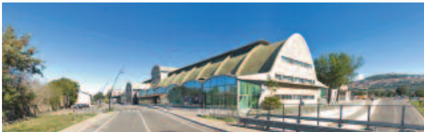
Area ex Montedison, Santa Maria degli Angeli, Assisi (Pg), vista d'insieme
