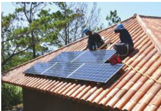
Figura 1: Pannello fotovoltaico costituito da celle al silicio integrato nel tetto di un edificio (in alto) [8].
