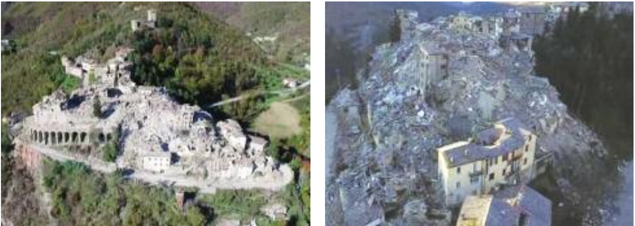
Fig. 5 - Effetti del sisma del 24 agosto 2016 ad Arquata del Tronto
