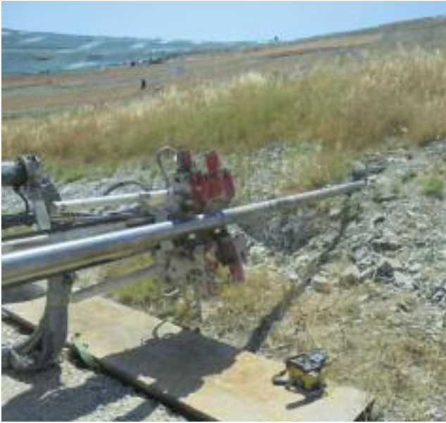
Particolare realizzazione dreni sub orizzontali corpi discarica
