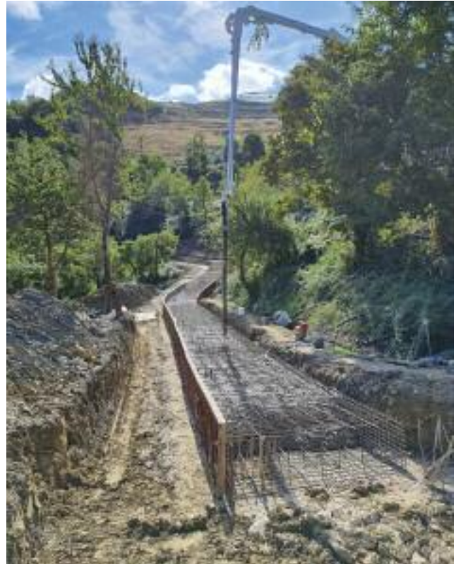
Armatura cordolo e getto allineamento pali
