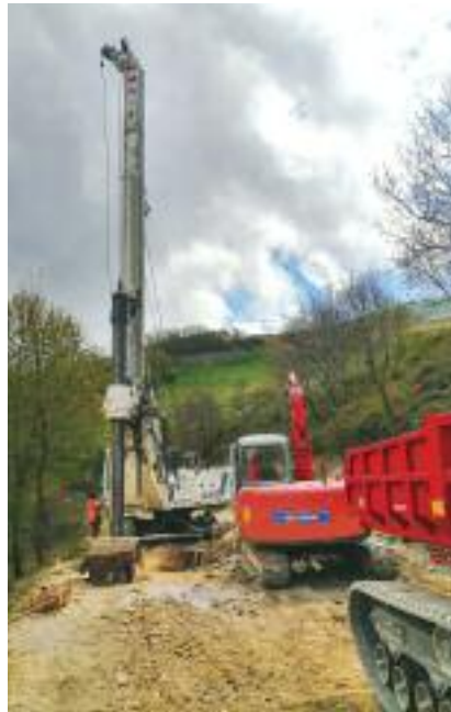
Realizzazione palo di consolidamento
