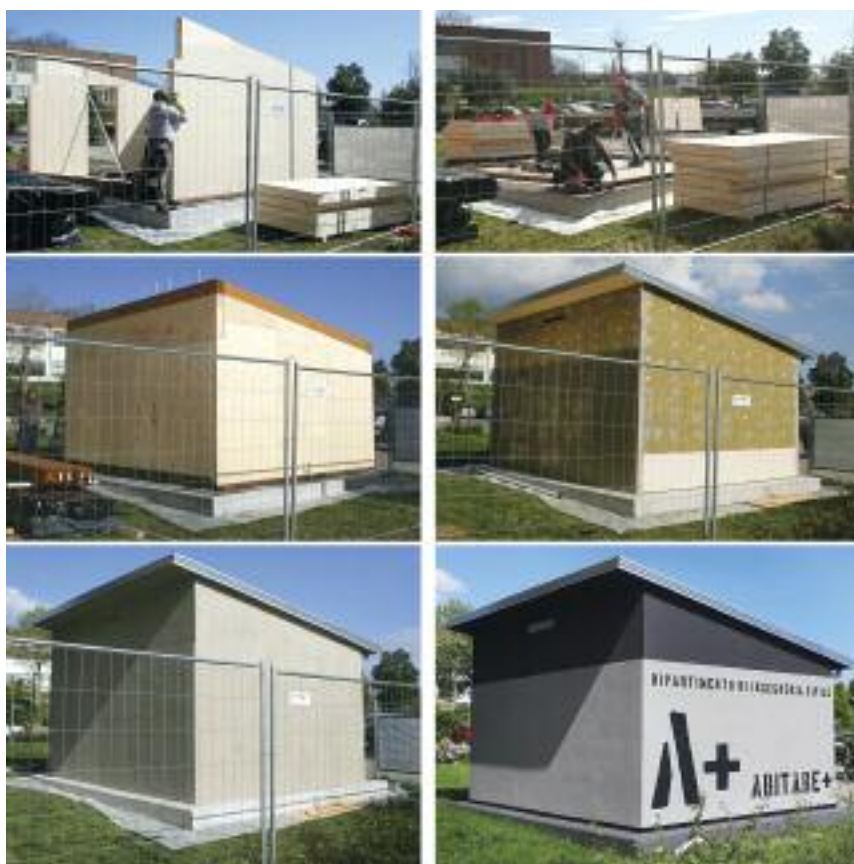
Fig. 2: fasi costruttive della test room presso il Dipartimento di Ingegneria Civile e Ambientale di Perugia
