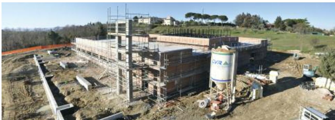
Vista dell'edificio in corso di realizzazione
