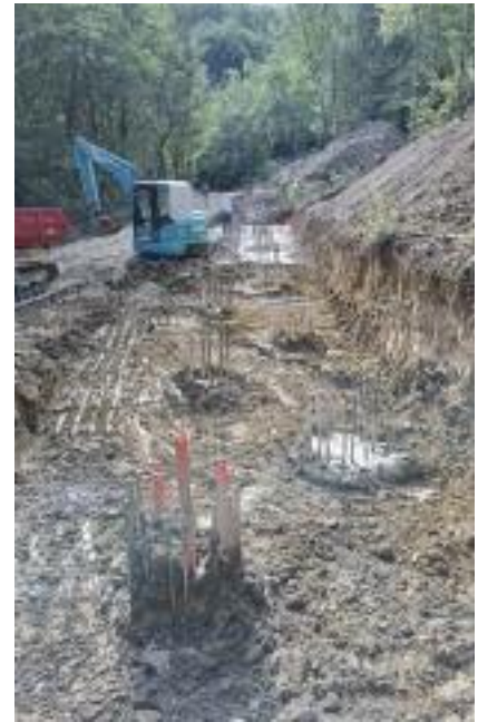
Panoramica realizzazione porzione palificata
