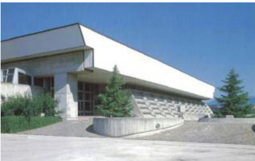
Stabilimento tipografico Campi - oggi Ormesa - Foligno
