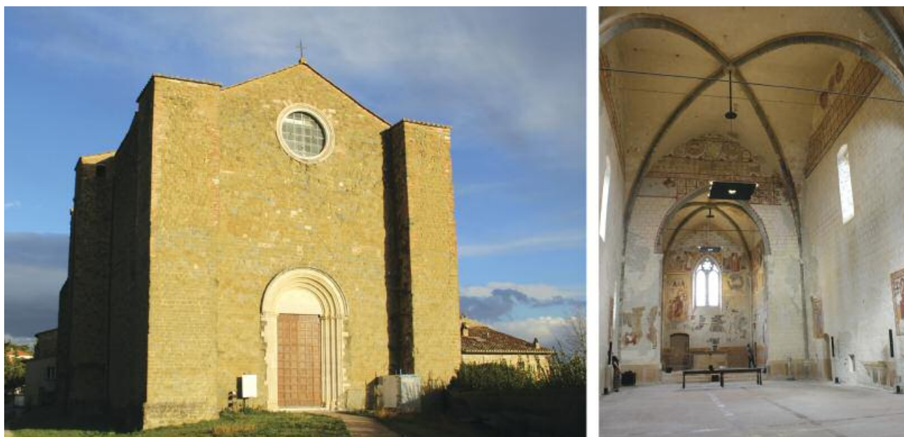
Fig. 1. Viste della chiesa di San Bevignate: facciata principale e navata. Foto: autore.
