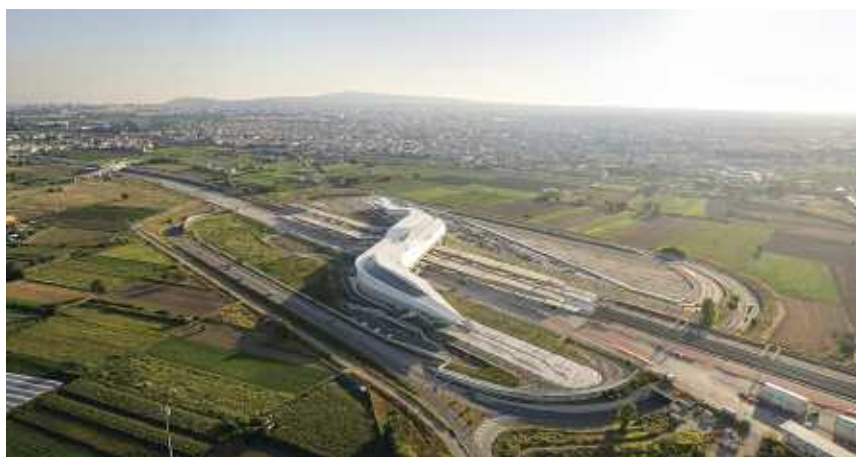
Vista dall'alto della Stazione AV di Afragola (Fotografia di Hufton+Crow per Zaha Hadid Architects)
