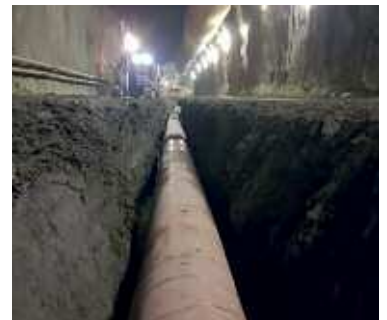
monoPiPe+ in PPHM monostrato (galleria base del Brennero)
