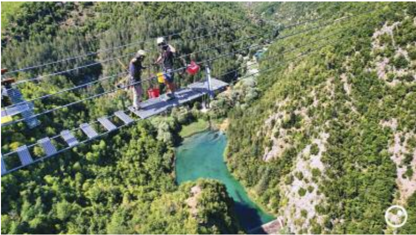
Figura 8 - Montaggio delle pedane
