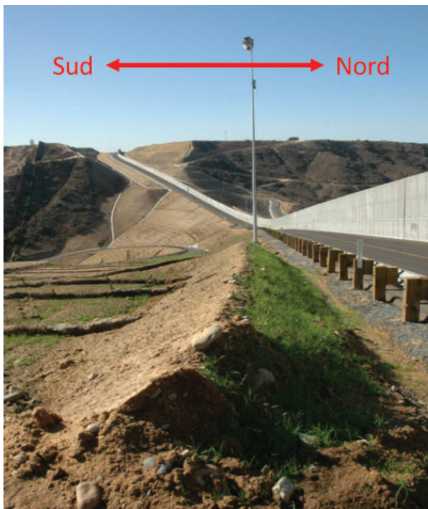
Figura 2: Infrastruttura viaria in Texas (San Angelo). Poche settimane dopo la realizzazione del rilevato in terra posto a margine della strada, il versante esposto a nord si è inerbito mentre quello esposto a sud è rimasto privo di vegetazione.
