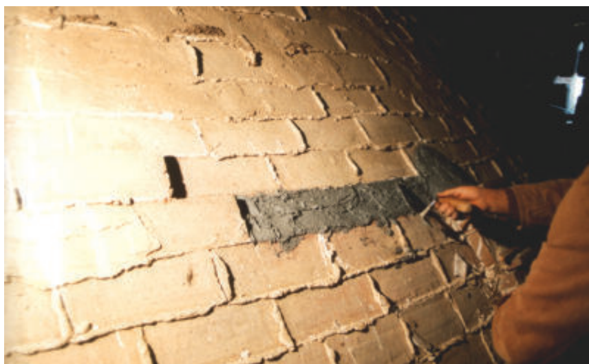
Figura 1 - Intervento di rinforzo con GFRP della cupola della chiesa di S. Biagio di Frassineto (AR) eseguito nel 1984.
