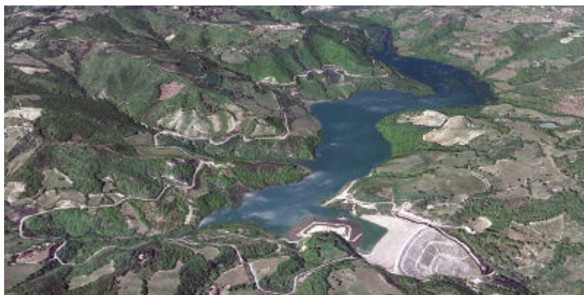
Immagine 2 - Veduta aerea della diga di Valfabbrica e del relativo bacino artificiale.
