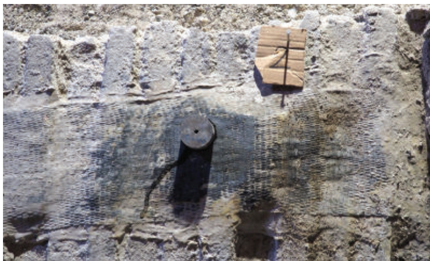
Figura 2 - La Cattedrale di San Feliciano di Foligno : campo prove per verificare l'efficacia degli interventi dopo vent'anni dall'applicazione avvenuta post sisma '97.
