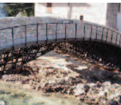
Figura 11: gli sbalzi laterali della centina in acciaio hanno consentito l'esecuzione in sicurezza dei rivestimenti dei parapetti
