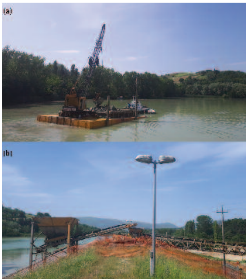
Fig. 4 - Attività di sfangamento presso il lago Le Grazie di Tolentino in corso di realizzazione: (a) escavatore con benna a valve posizionato su un mezzo nautico; (b) sistema di tramoggia e nastro trasportatore per il sormonto del rilevato arginale e il conferimento del sedimento nel punto di stoccaggio
