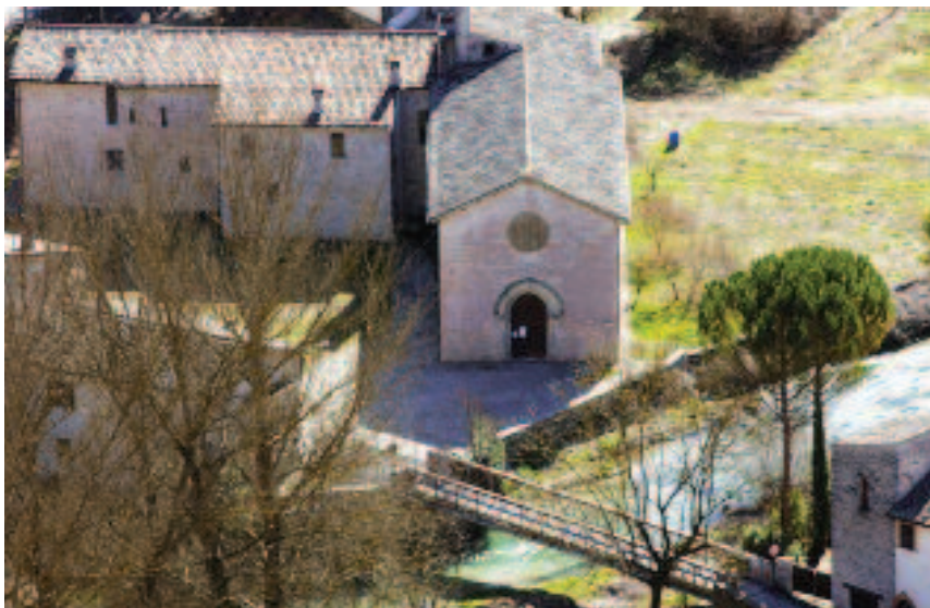
Figura 2: vista sulla chiesa di San Lorenzo e sull'annesso convento francescano, in sinistra del Nera a Borgo Cerreto. In basso la passerella in carpenteria metallica da adeguare ( http://www.lavalnerina.it )
