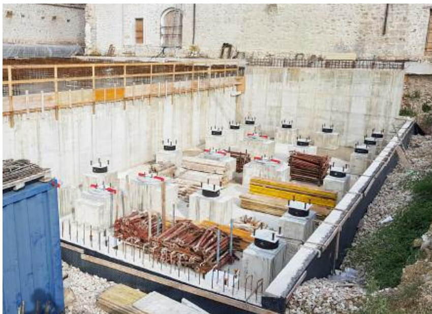
Figura 3: Fase di realizzazione del sistema fondale (Immagine di ing. Michele Pelliccia)
