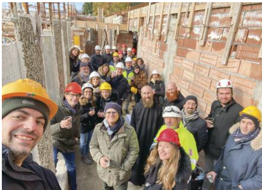
Figura 5: Ingegneri in visita al sistema fondale (Fotografia di ing. Massimo Palombo)
