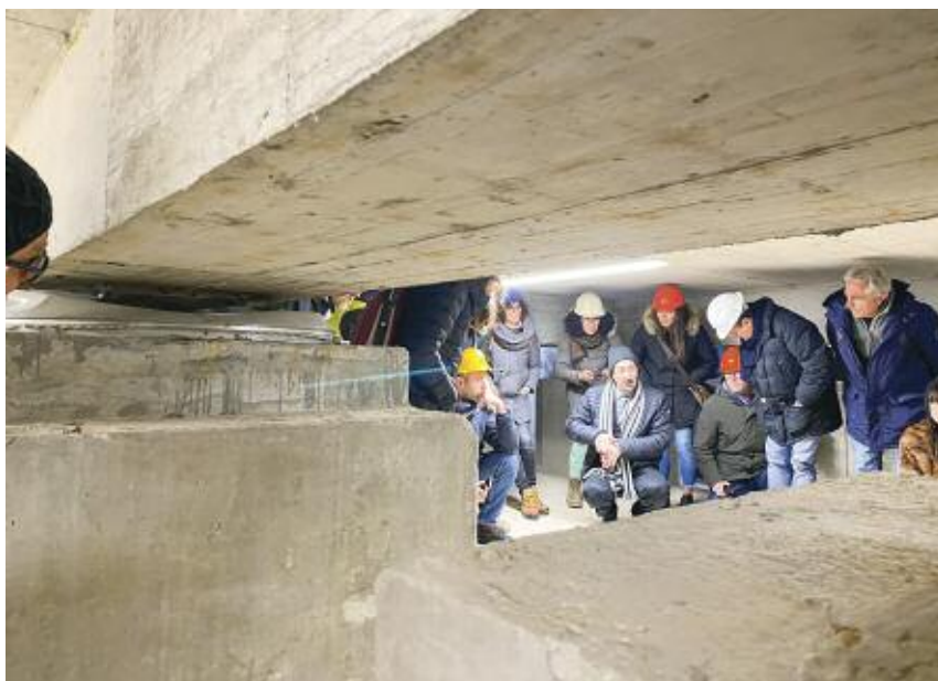
Figura 4: Ingegneri in visita al sistema fondale (Fotografia di ing. Massimo Palombo)
