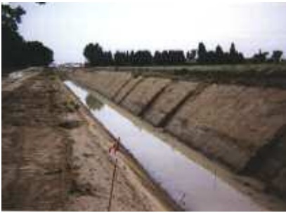
Figura 5A. Esecuzione lavori
