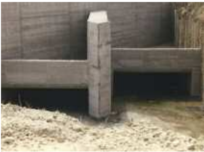
Figura 5B. Esecuzione lavori
