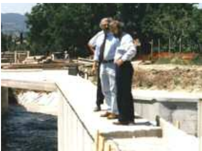
Figura 5D. Esecuzione lavori
