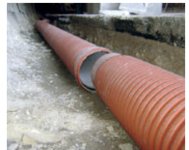
Sedici plus in PPHM doppio strato installato in galleria
