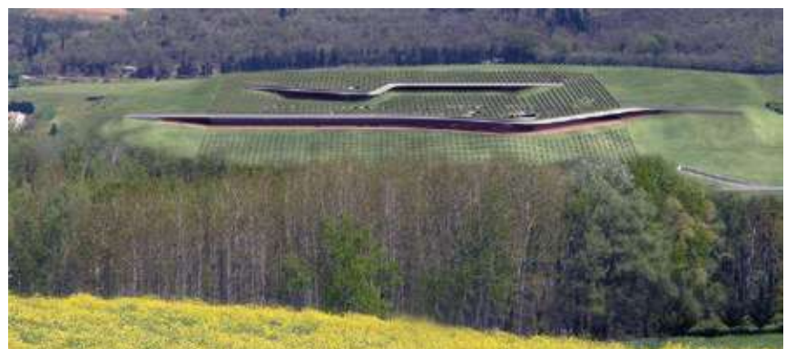
Figura 7 - Vista frontale della Cantina Antinori a Bargino. Tagli nella collina. Fotografia di Archea Associati
