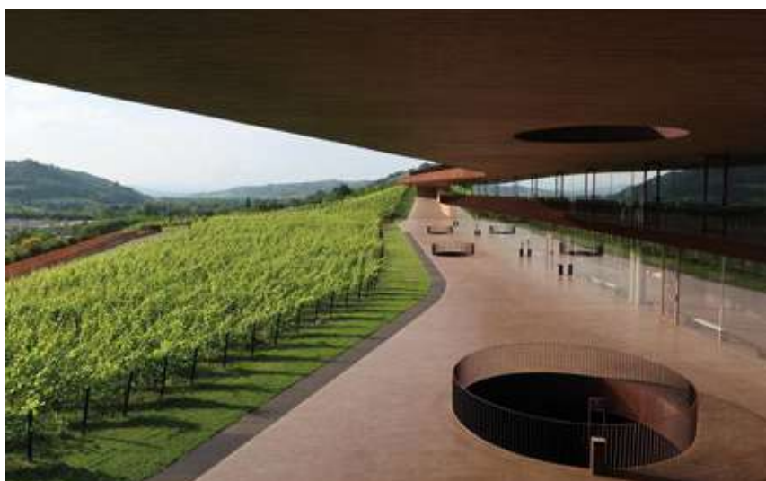
Figura 10 - Il terrazzamento inferiore e l'ingresso all'area di accoglienza dei visitatori della Cantina Antinori. Fotografia di Massimo Palombo
