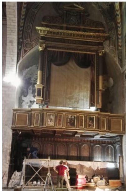
Figura 5 – Interventi strutturali ultimati
