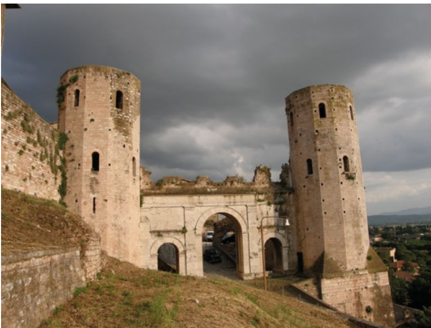
Figura 4- Stato delle Torri di Properzio prima dell'intervento di restauro
