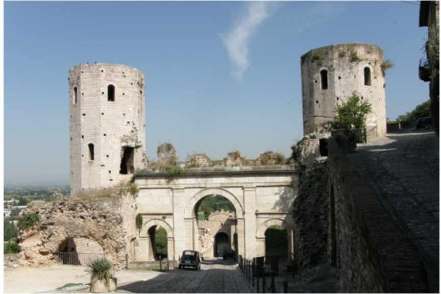
Figura 3- Stato delle Torri di Properzio prima dell'intervento di restauro
