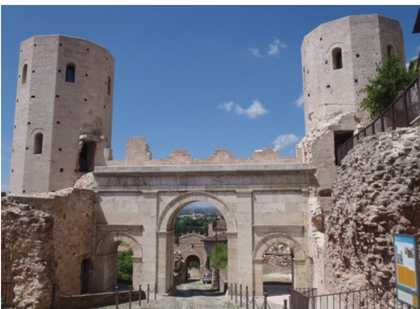
Figura 10- Torri di Properzio dopo l'intervento di restauro
