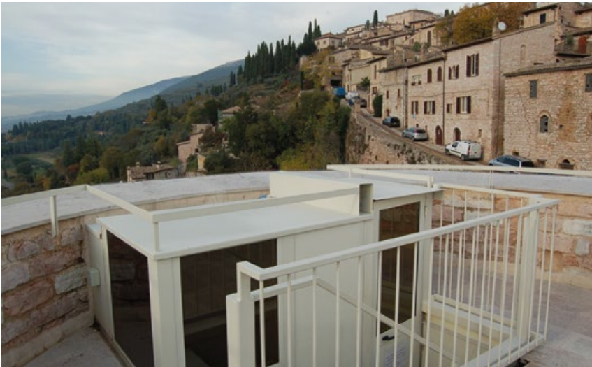
Figura 8- Torre a Valle lastrico solare
