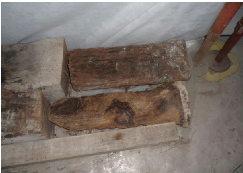
Figura 2 – Ammaloramento travi
