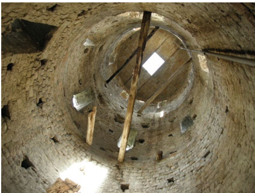
Figura 5- Vista interna Torre a Valle prima dell'intervento di restauro
