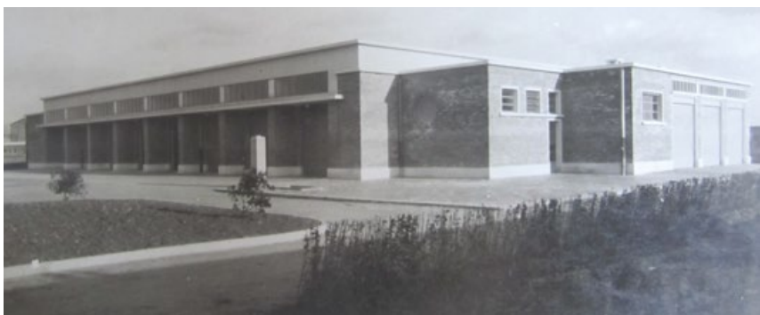
Figura 7 – L'autorimessa e il parco antincendi, 1938.
