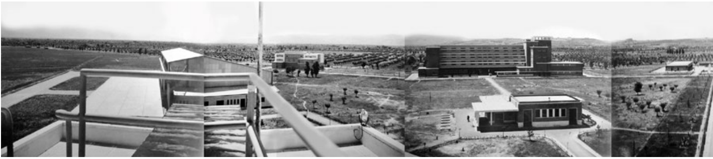
Figura 2 – Panoramica dell'Aeroporto effettuata dalla palazzina comando, 1938.
