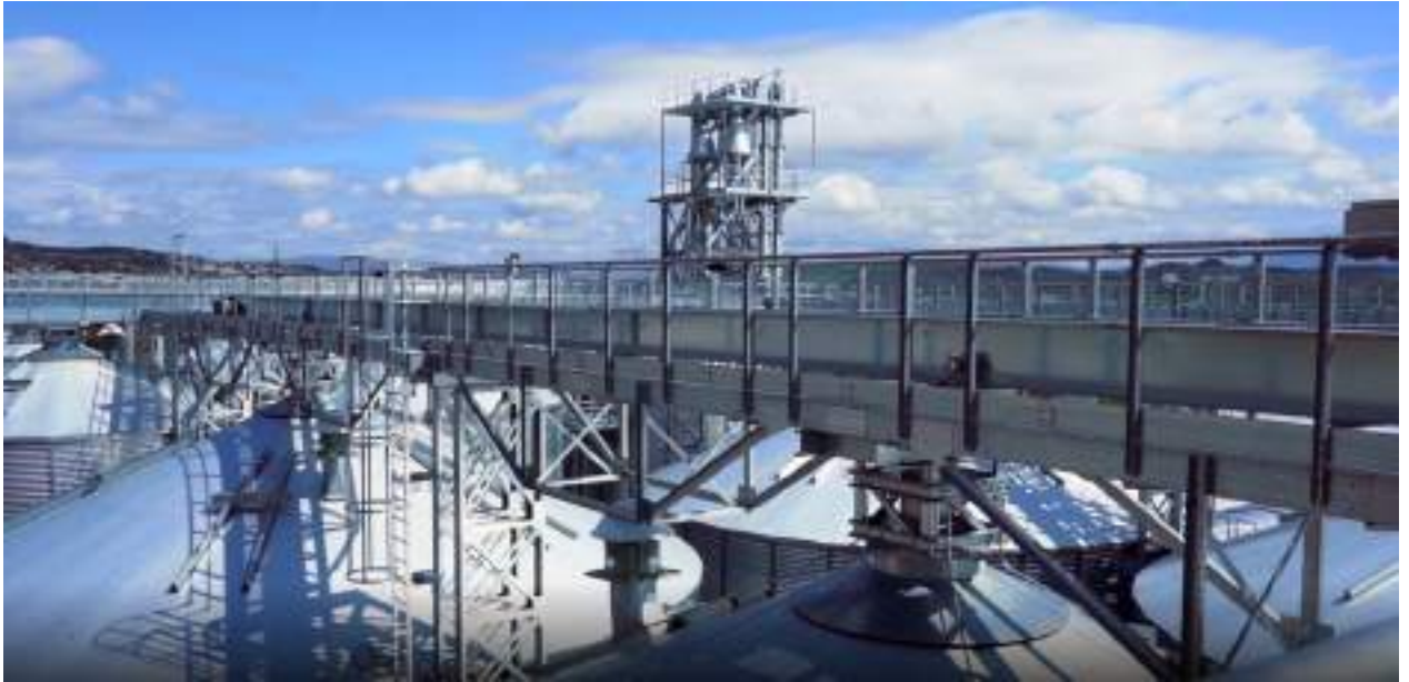
2015-2016 Perugia Progettazione e Direzione dei Lavori delle strutture della nuova sede della Manganeli S.p.A. sita in Perugia località Madonna del Piano
