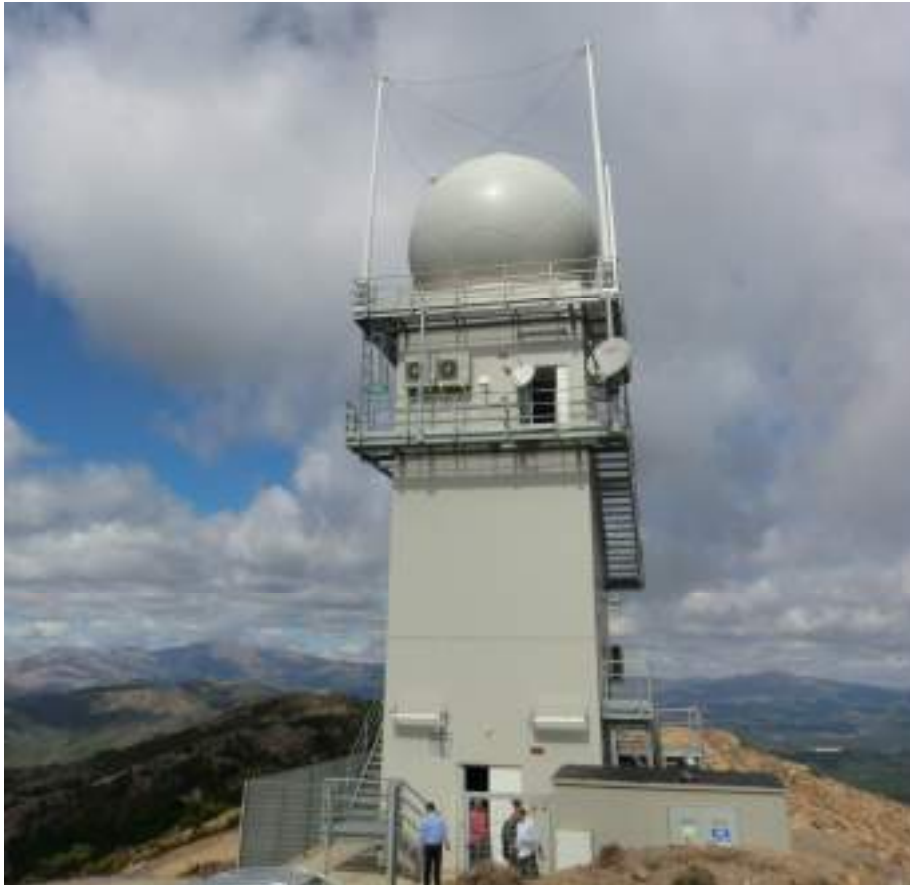
2013-2016 Gairo (OG) Direzione lavori delle opere civili della rete radar meteo nazionale: sito di Monte Armidda
